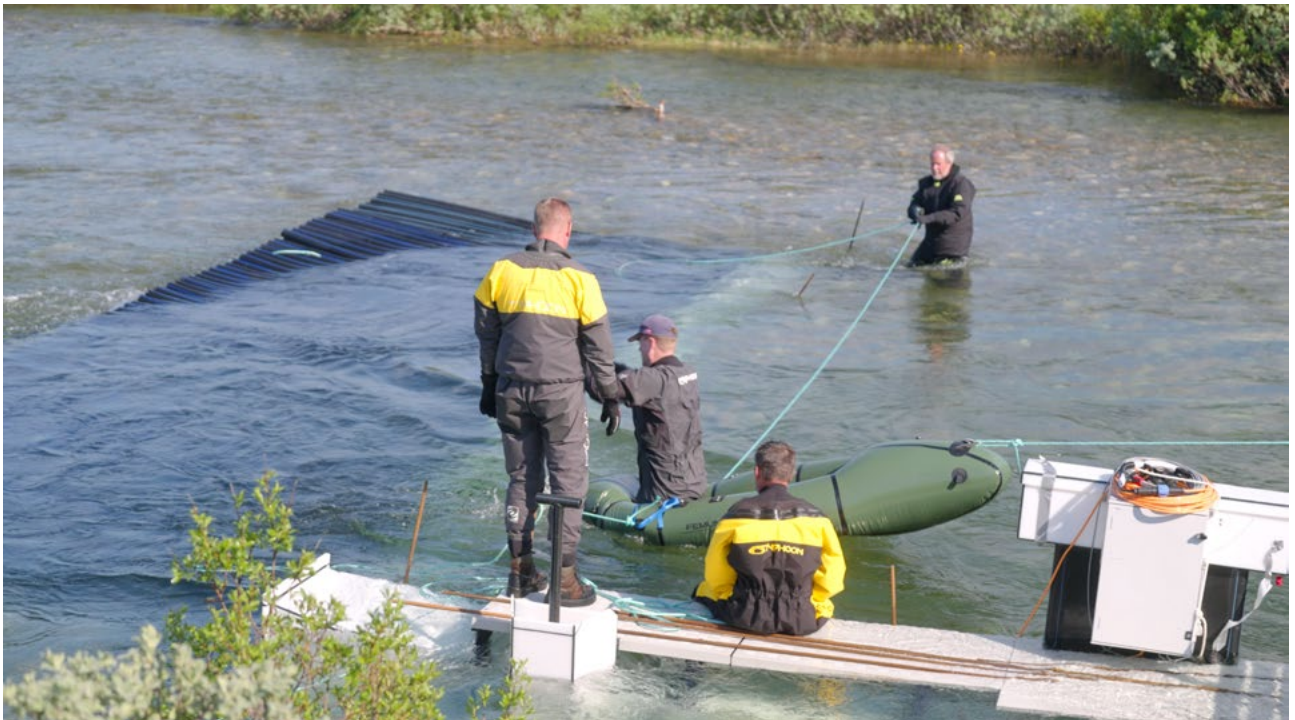
华为和伙伴在挪威 Storelva 河安装三文鱼智能分流系统
